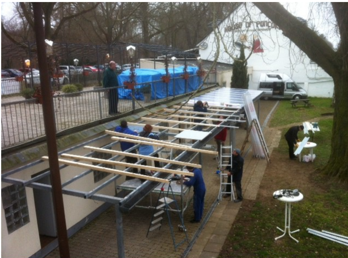
Bau des Schleppdaches im Frühjahr 2016
